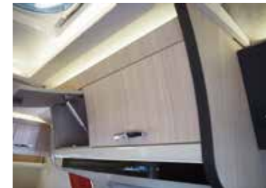
ギャレ上部吊り戸棚
