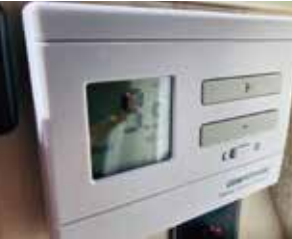
2 室温設定スイッチ室温センサー付
