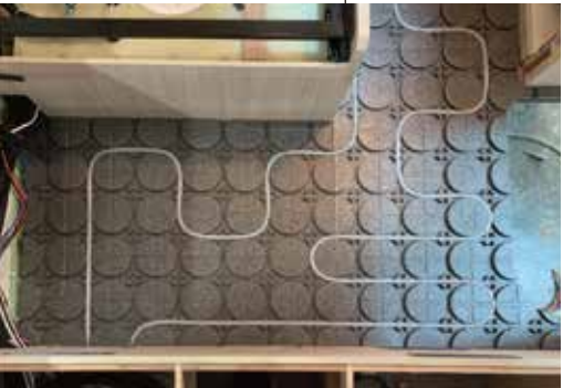
床下に施工された床暖房パネル・配管
